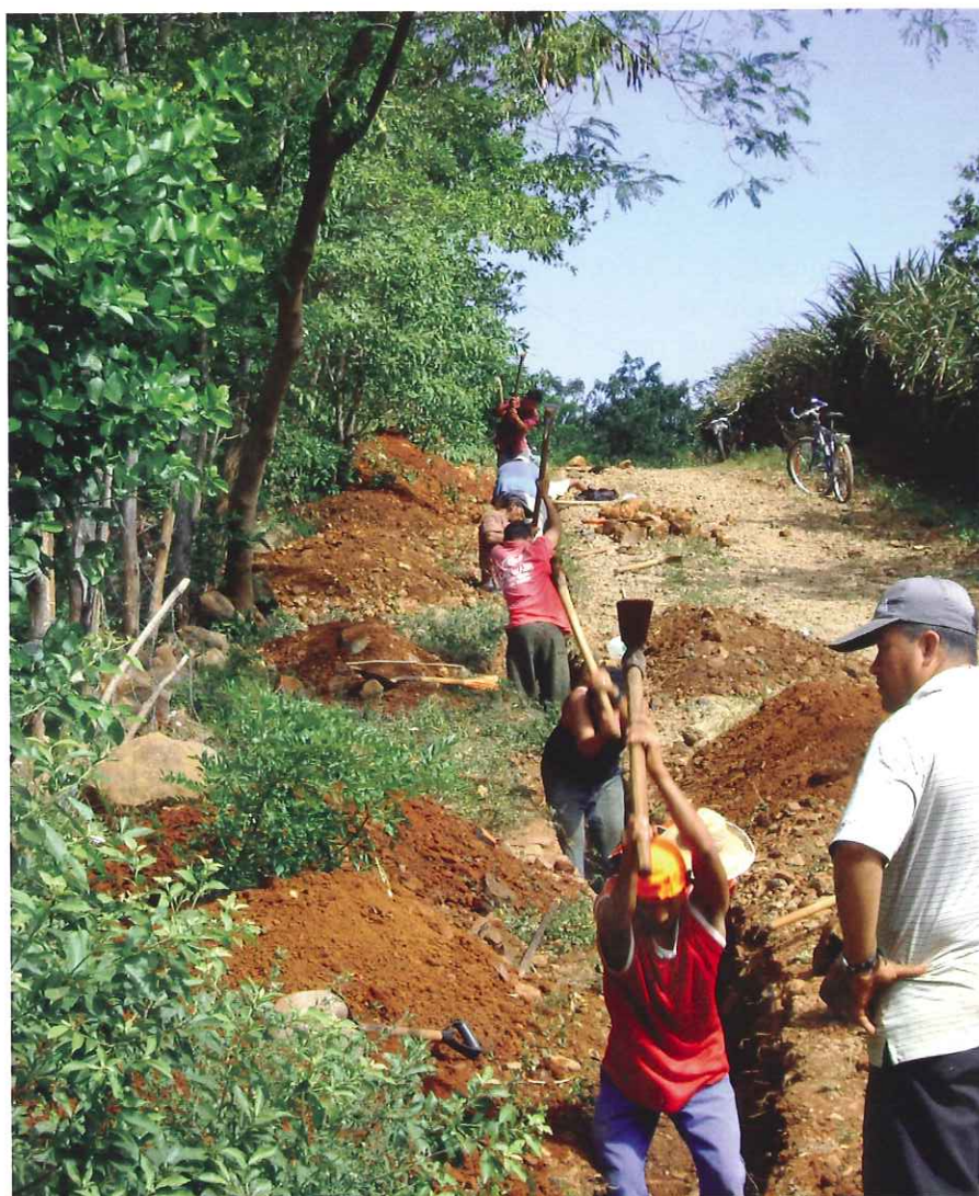
Figura 2. Aperturas de zanjas.
