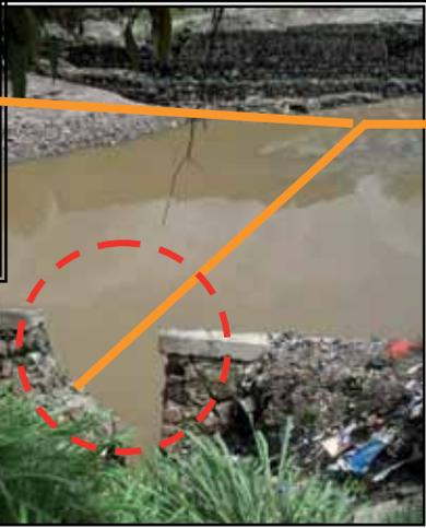
Muro de Contención en ladera colapsado contiguo a Río Acelhuate y Calle San Martín h=15m
