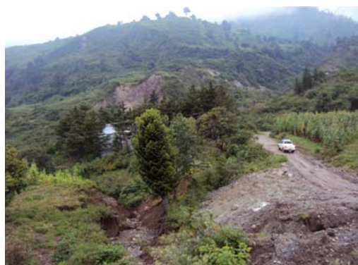
Deslizamiento que afecta a la carretera
