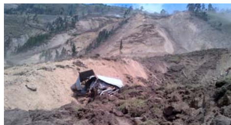
Deslizamiento en Tumba San Francisco
