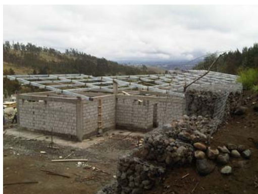
Construcción de la escuela
