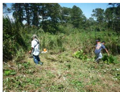
Limpieza del terreno
