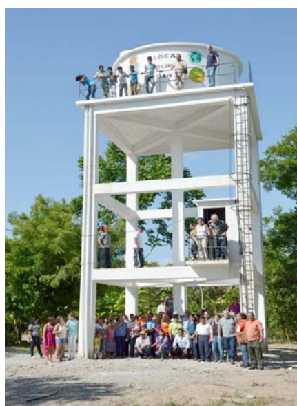
Tanque de agua
