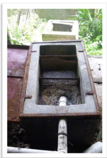
FOTOGRAFÍA DE DETALLE DE UN CAJÓN TRAMPA-GRASA instalado en las inmediaciones del Lago de Yojoa para evitar que los restaurantes de la zona desagüen y viertan residuos sólidos al lago. Se puede observar su correcto funcionamiento al quedar depositadas en las cubetas la materia sólida procedente del lavado de los útiles de cocina y restos de comida.
